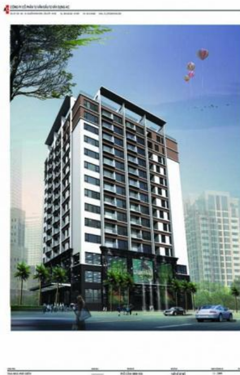
Hình ảnh dự án Công trình hỗn hợp nhà ở chung cư cao tầng 134
